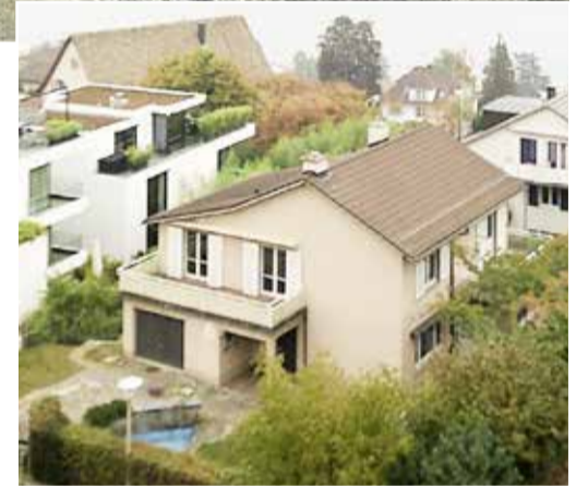
Das ursprüngliche Haus erhielt im Zuge des Um- bzw. Weiterbaus ein drittes Geschoss mit Terrasse anstelle des Schrägdachs. BILD ZVG
